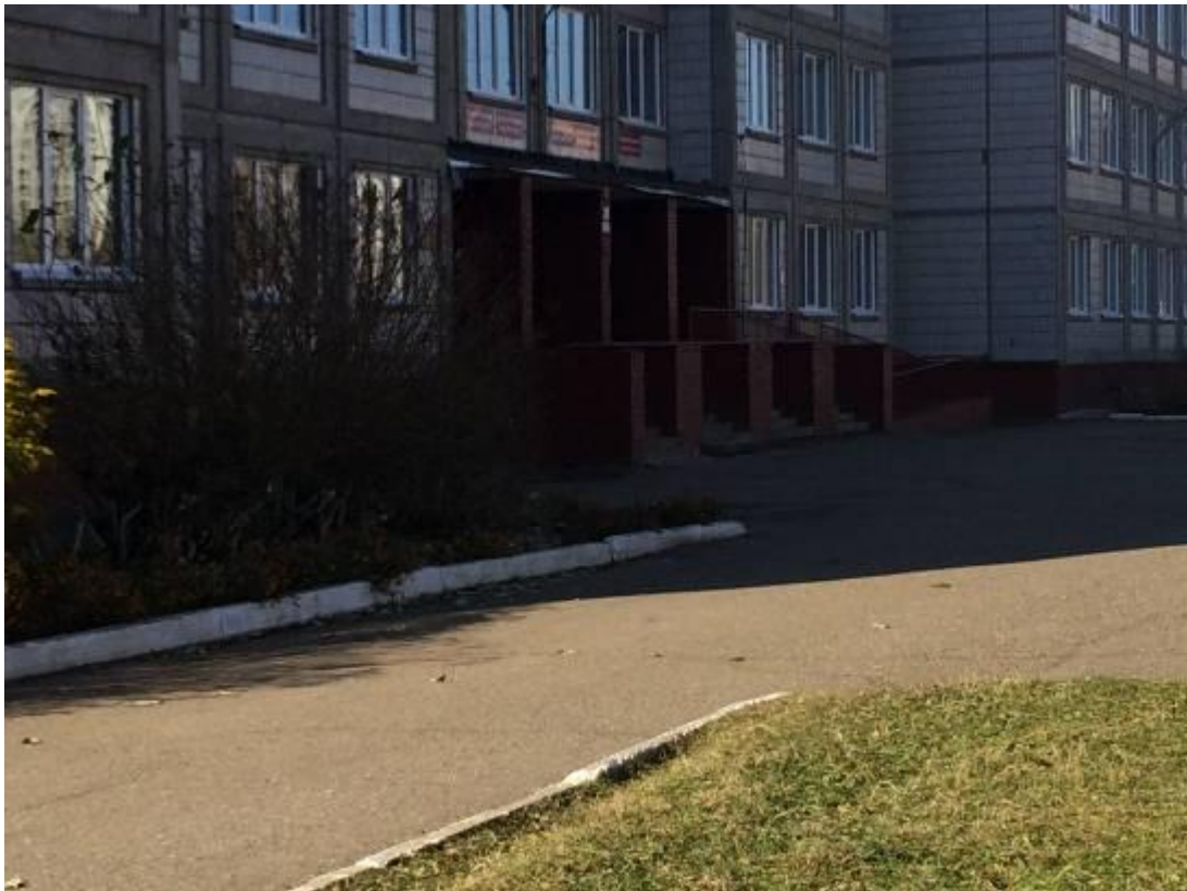
Фото 3 Лестница наружная и автостоянка для транспорта инвалидов
